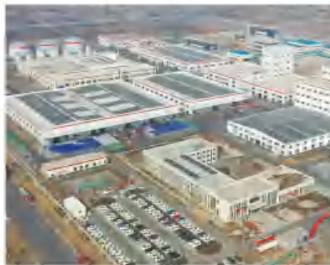
东方雨虹濮阳光伏电站项目
