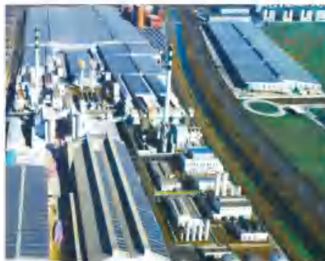
天津武清区工业园、敬华家具工业园等项目
