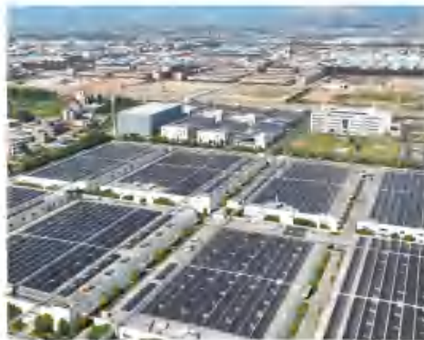
华峰华锦集团光伏电站项目
